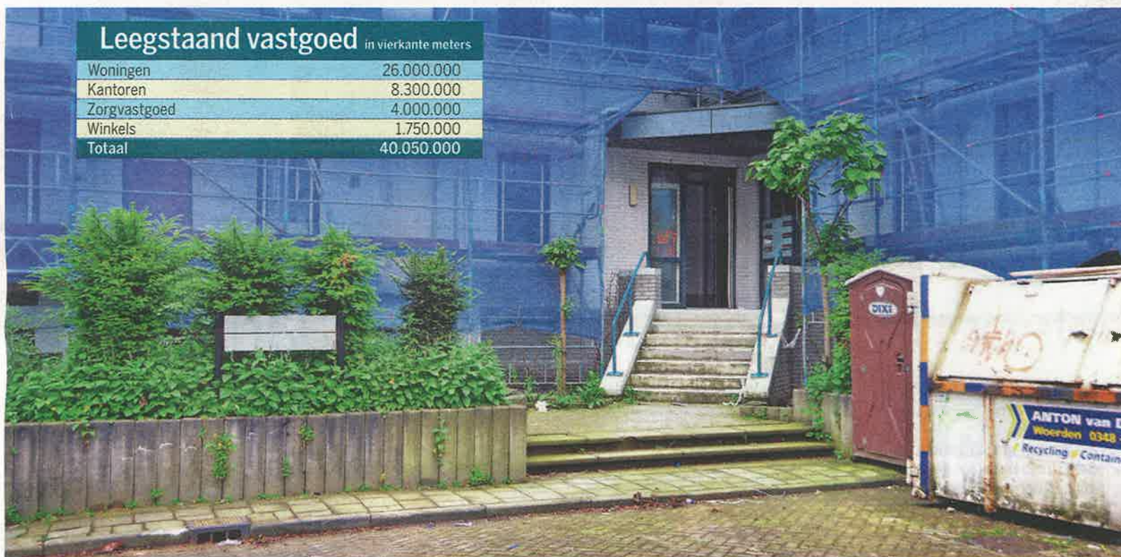
Herbestemming in Nieuwegein: Van leperen verbouwt een leegstaand kantoorpand tot appartementencomplex. Foto: Ton Borsboom
