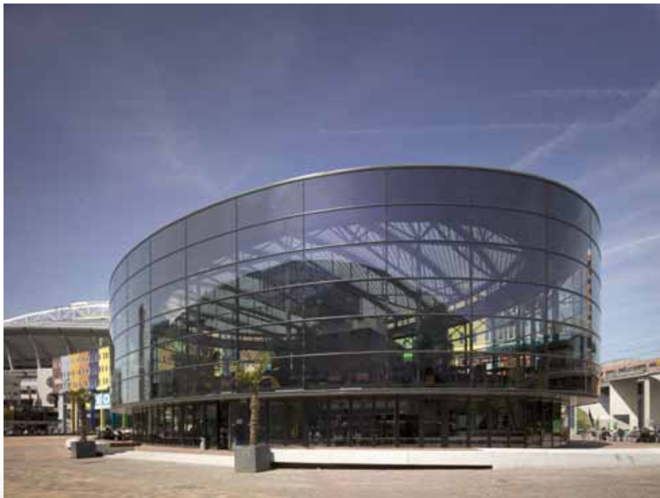
Figuur 2. Het Jinso-paviljoen met een gevel van koud-gebogen isolatieglas in straal verlopend van circa elf naar dertig meter
