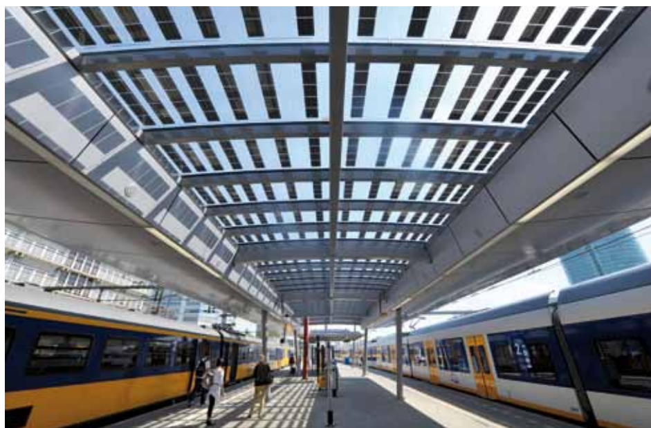
Figuur 4. Ook de perronkappen van Utrecht Centraal worden voorzien van lichtstraten met Freeformglass met geïntegreerde zonnecellen
