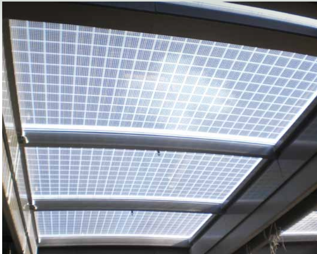
Figuur 6. Een diffuse verlichting door perforatie van de zonnecellen in het hoofdkantoor van Van Leeuwen Buizen te Zwijndrecht
