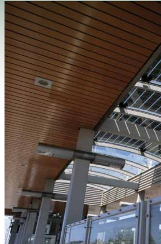
Figuur 3. Freeformglass met geïntegreerde zonnecellen voor het eerst toegepast bij station Utrecht-Zuilen
